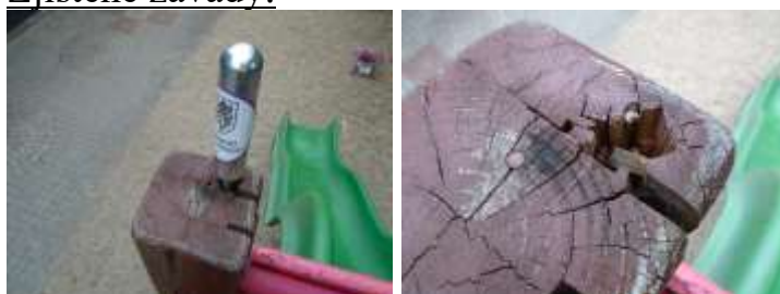
1) Hniloba stojiny v horní části u skluzu
