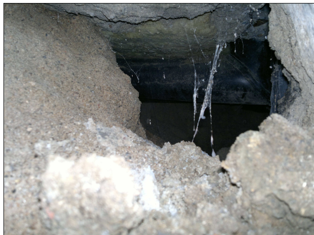
Foto /3/ - Podhled do kaverny za pilotou, patrné blíže neznámé potrubí(černé) a odpad z kuchyně (vpravo)
