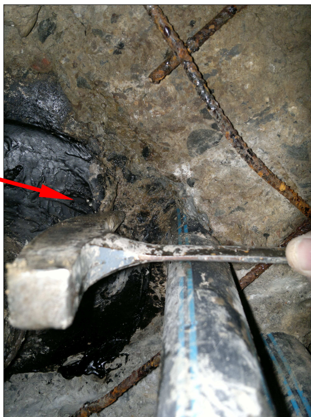
Foto /5/ - Opracování prostupu nesoudržné s asfaltem na podkladním betonu
