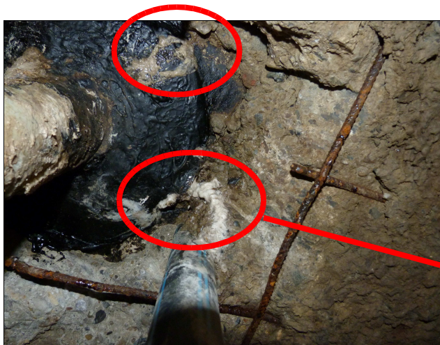
Foto /2/ - Podhled do kaverny v místě chrániček, krápníky svědčí o dlouhodobější existenci kaverny
