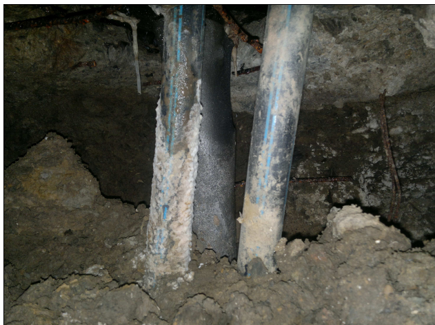
Foto /2/ - Podhled do kaverny v místě chrániček, krápníky svědčí o dlouhodobější existenci kaverny
