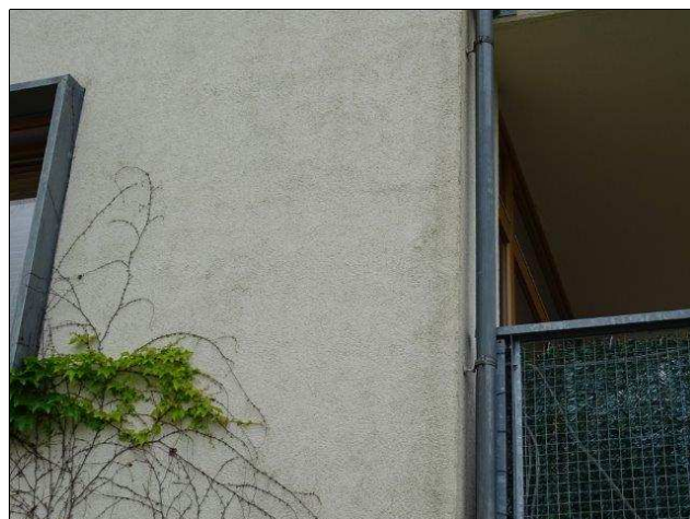
foto /27/ Výskyt biotického napadení fasády – objekt B
