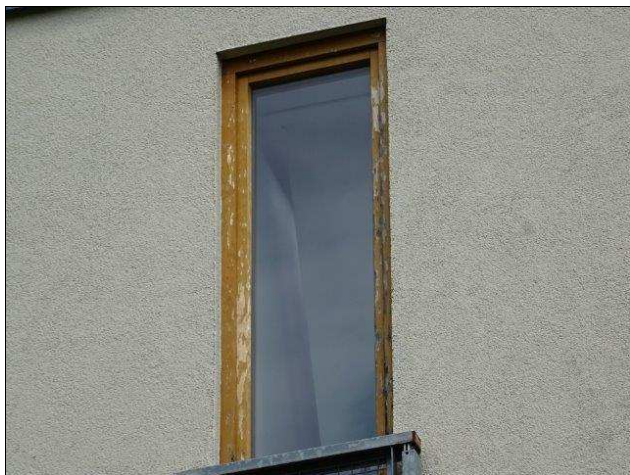
foto /39/ Dřevěné výplně otvorů
