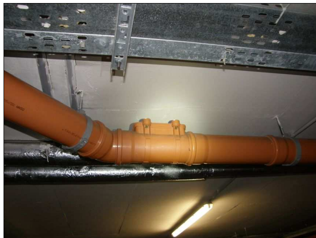
foto /76/ Revizní kus natočený směrem ke stropu, obtížný přístup
