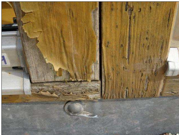
foto /43/ Degradace povrchových úprav dřevěných výplní otvorů
