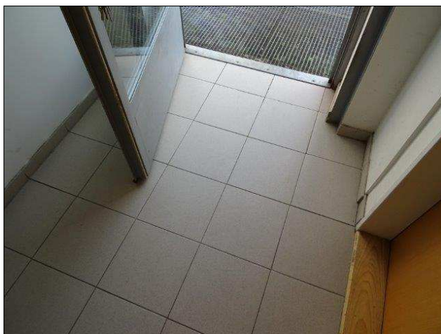
foto /55/ Zádveří na chodbě objektu č.p. 10
