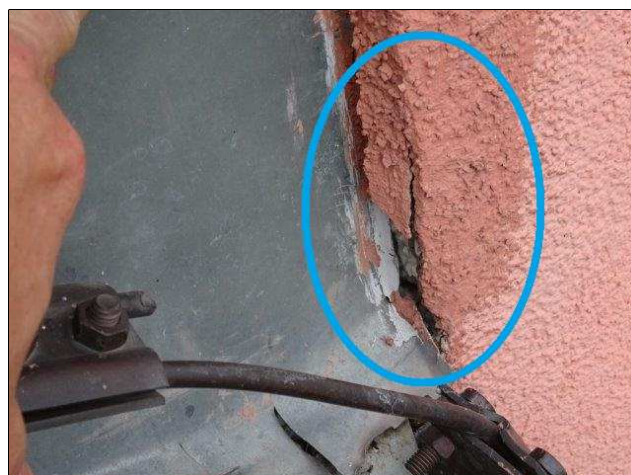
foto /25/ Ukončení oplechování soklu u severozápadního rohu objektu C2 (v úrovni 4.NP)
