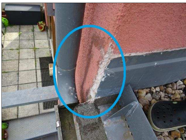
foto /24/ Provedená oprava detailu soklu v úrovni 4.NP objektu C1
