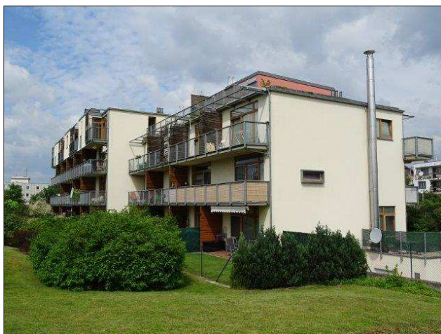
foto /1/ Pohled na objekt od východu
