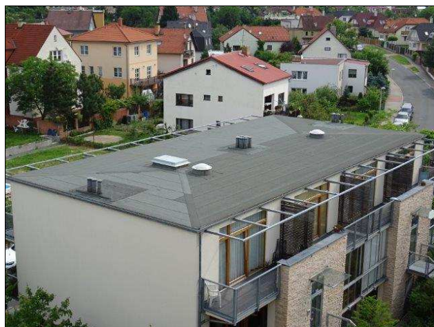
foto /3/ Pohled na střechu objektu A
