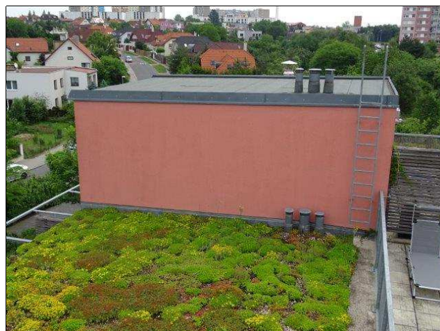
foto /6/ Pohled na střechu objektu C5 a C6
