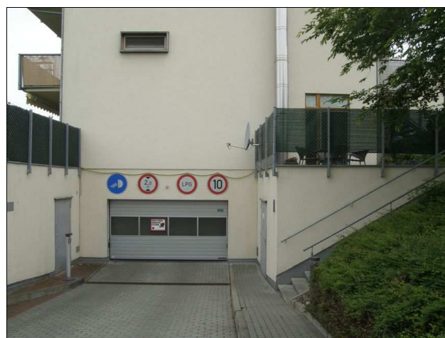
foto /74/ Vjezdová vrata s nasávacími otvory
