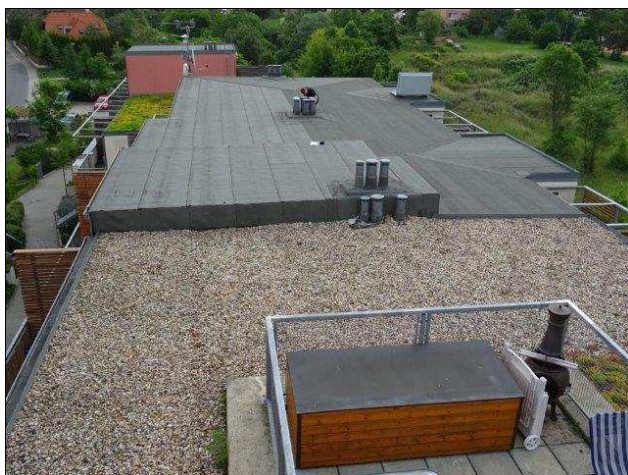
foto /5/ Pohled na střechu objektu C2 až C4
