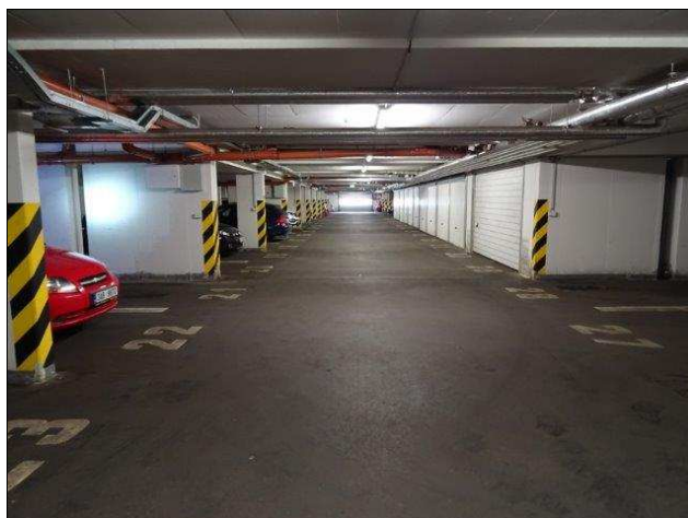
foto /30/ Podzemní podlaží – garáže objektu
