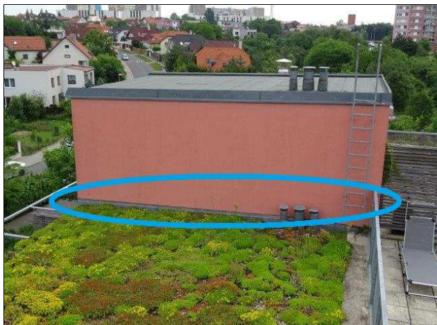
foto /20/ Pohled na fasádu 4.NP objektu C6
