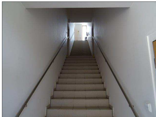
foto /54/ Chodba objekt č.p. 8a
