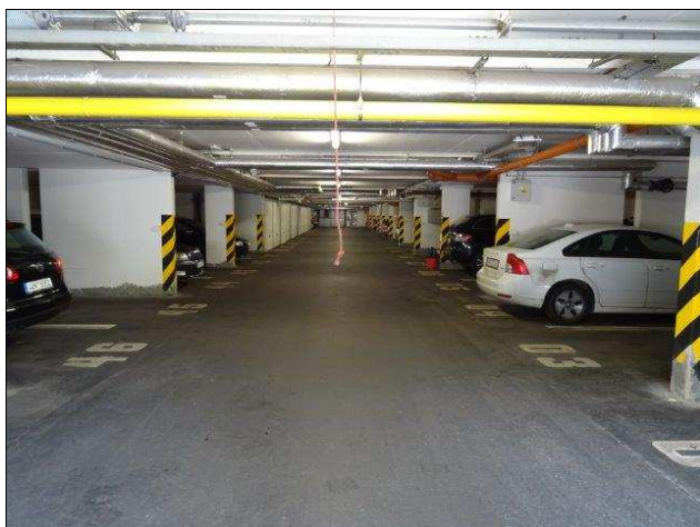
foto /29/ Podzemní podlaží – garáže objektu
