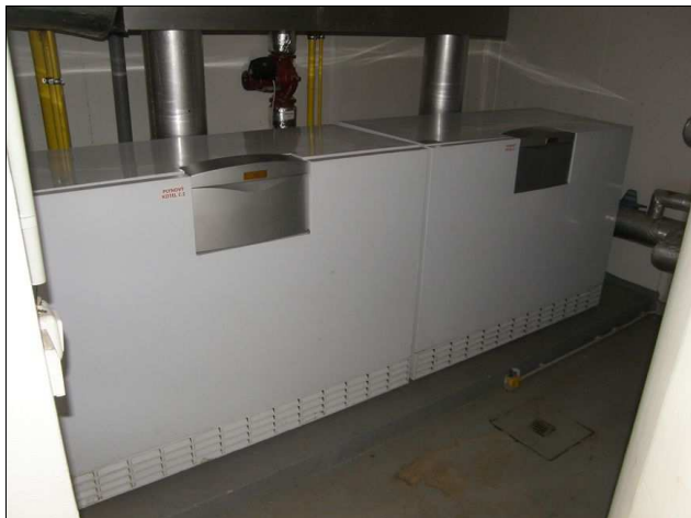
foto /77/ Zdroj tepla – dvojice plynových kotlů Vaillant atmoCRAFT
