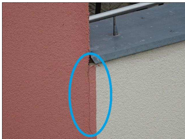
foto /26/ Trhlina v místě napojení krčku mezi objekty C1 a B
